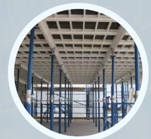
Учитывая запросы строительных компаний и возможность многократного использования оборудования, опалубка перекрытий Kumkang Kind позволяет максимально увеличить производительность работ. Её использование обеспечивает высочайший уровень безопасности для рабочих. Замена фиксированных головок на падающие головки позволяет значительно снизить риск падения материалов и уровень шума во время демонтажа опалубки.
