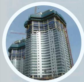
Накопив ряд технологий, мы успешно разработали самоподъемную систему наружного контура здания, использующую гидравлику для подъема конструкции. Успешно используя известные качества других подъемных систем, наша разработка приспособлена к большинству наиболее сложных задач, стоящих перед строителями.
