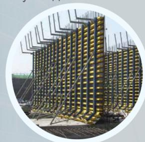
Опалубка с использованием деревянных балок представляет собой классическую систему опалубки для больших поверхностей. Она выполняется из фанеры, деревянных балок и стальных ригелей и применяется для конструкций любых форм на различных строительных площадках - например, для строительства фундаментов, стен, разделительных стенок, ограждений, причальных стенок и мостов.
