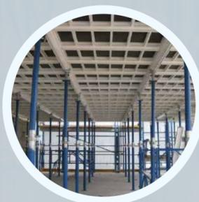
Considerando o projeto de construção e o repetitivo uso de moldes, o sistema da laje Kumkang Kind maximiza a eficiência do trabalho pelo desenho do molde para ser monolítico e fixo. Portanto aumenta grandemente a segurança dos trabalhadores. Pelo sistema de escoramento superior, garante a segurança de quedas de materiais e problemas de ruído, foram reduzidos enquanto a desmontagem foi consideravelmente melhorada.
