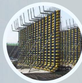
Os moldes de vigas de Madeira é um sistema clássico de moldes em larga escala que também é chamado de molde de madeira compensada composta de madeira compensada, viga de madeira e aço waling. Pode ser aplicado a qualquer forma de estrutura e a qualquer tipo de canteiro de obras como de fundação, paredes, paredes de face única, paredes de retenção, cais e pontes.
